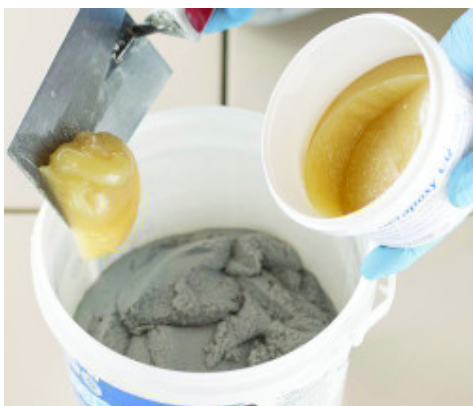
Ρίξτε το σκληρυντικό (συστατικό Β) στο δοχείο του συστατικού Α
