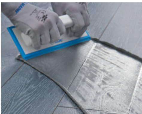
Απλώμα Ultracolor Plus με λαστιχένια σπάτουλα σε δάπεδο με πλακίδια τεχνητού γρανίτη
