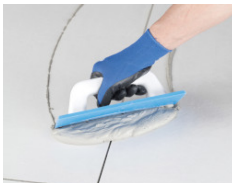
Τοποθέτηση Ultracolor Plus σε δάπεδο με λαστιχένια σπάτουλα σε πλακίδια τεχνητού γρανίτη
