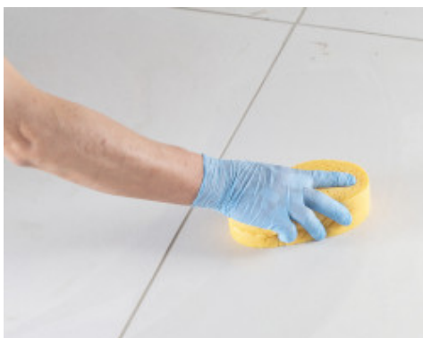
Καθαρισμός και φινιρίσμα του αρμόστοκου με σκληρό σφουγγάρι κυταρίνης
