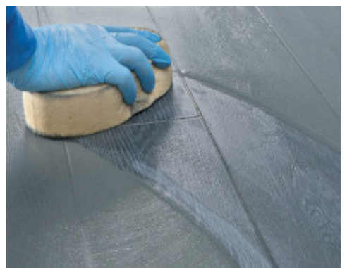
Τελείωμα και καθαρισμός αρμών με σκληρό κίτρινο σφουγγάρι κυταρίνης
